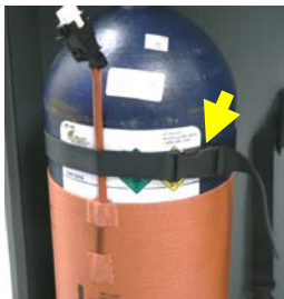
Figura 3a- Tira de retención del tanque
